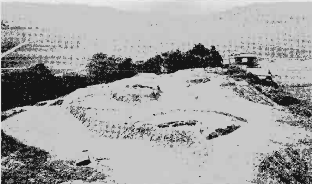
3. I区調査後 (南東から)
