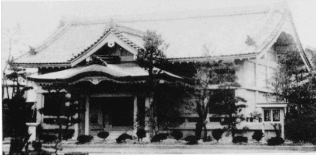
図1 完成当時の郷土館
