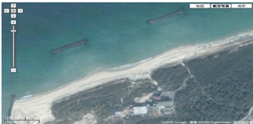
図2 さつき松原海岸の離岸堤と消波ブロック
