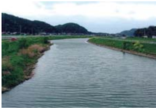
上多礼橋より下流方面を見る 2006. 4. 14
