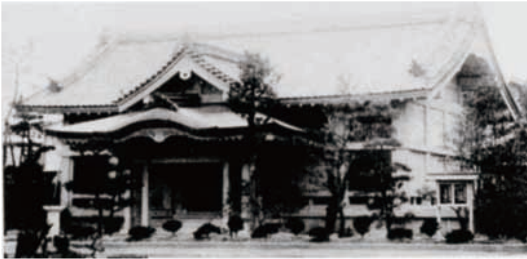
図1 完成当時の郷土館
